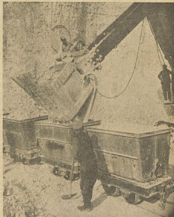
Le chargement des wagonnets par la pelle mécanique.
