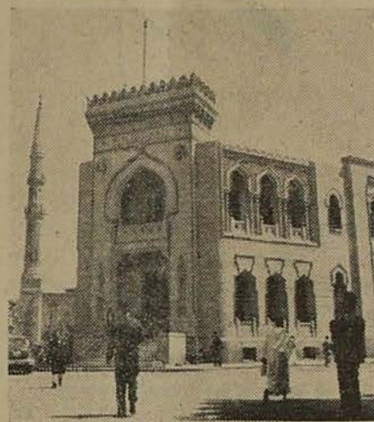
Entrée de l'Université d'El Azhar. A côté le minaret de la mosquée de Sayedna Hussein.
