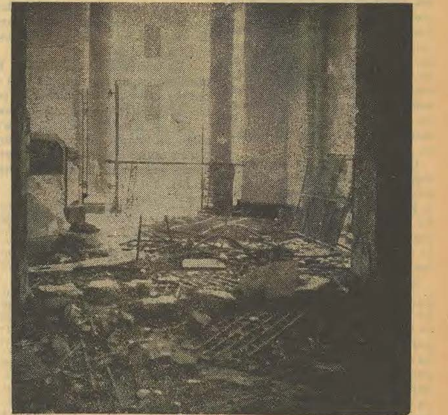
Une vue de désolation
