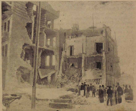
Immeubles atteints de coups directs durant les bombardements d'Alexandrie par l'aviation ennemie.
