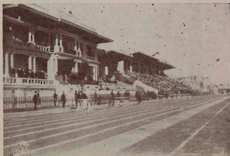
Une vue générale des tribunes qui constitue une belle réalisation architecturale due au talent de l'architecte Nichossoff.
