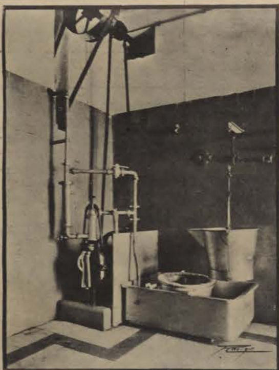
Pesage, filtrage et transmission du lait à l'aide de la pompe au pasteurisateur.
