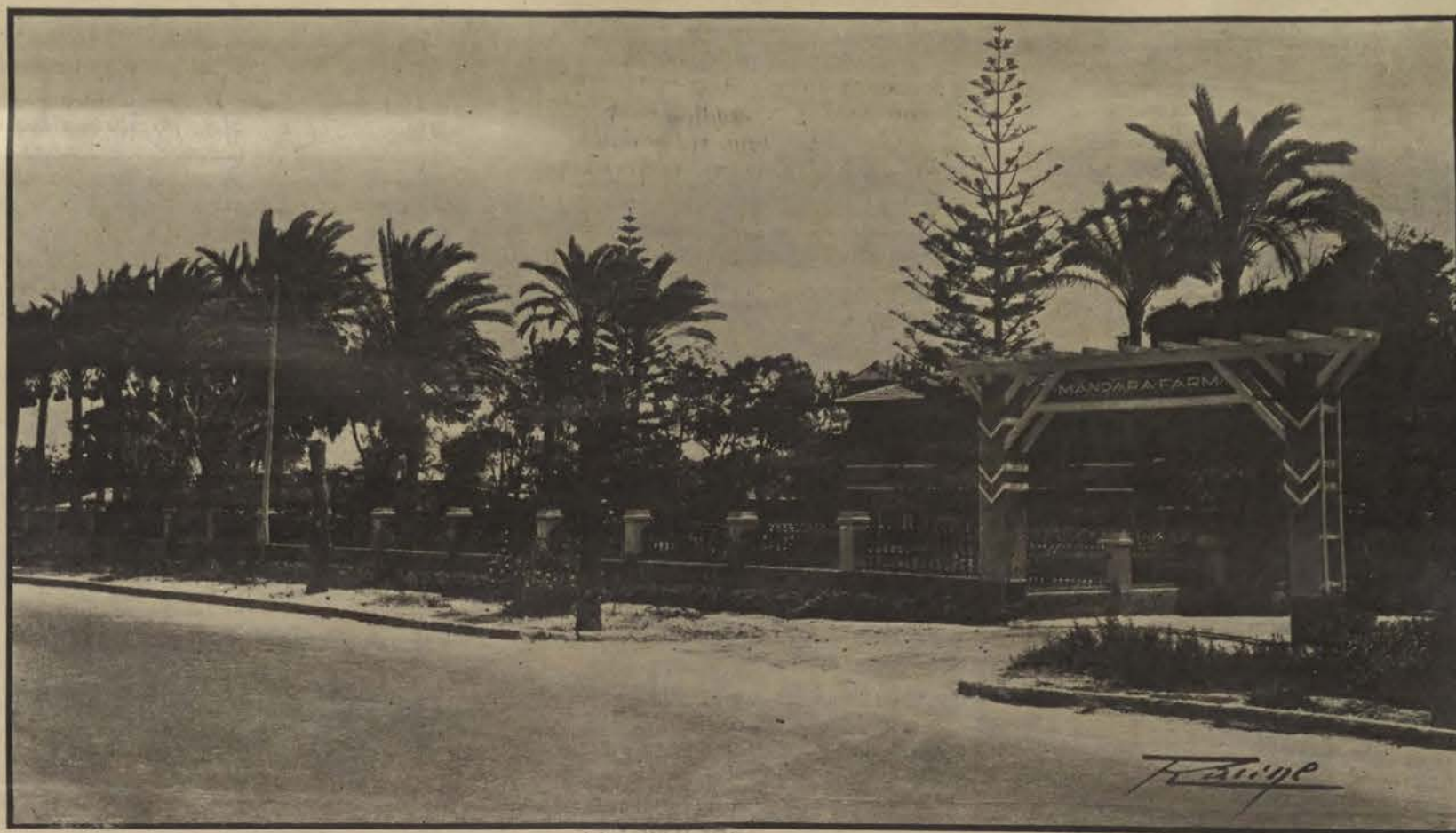
Entrée principale de la Mandara Farm.
