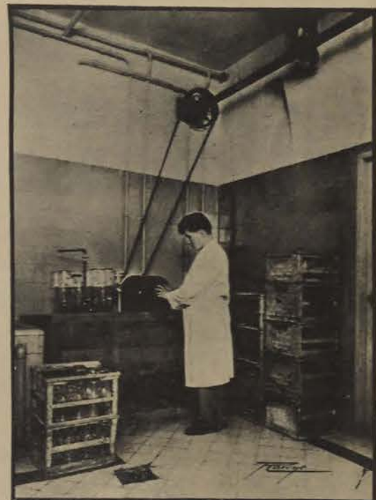
Le lavage des bouteilles à l'eau chaude et à la vapeur.
