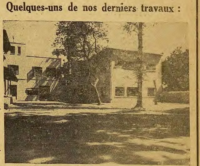
Anciens bureaux après rénovation. Nouveaux bureaux, murs et terrasses isolés contre la chaleur.
