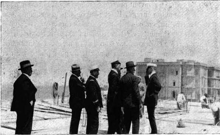
Le Commandant DUMONT et son Etat-Major Photo Pasquet sur le chantier du nouveau Collège Saint-Marc à Chatby.
