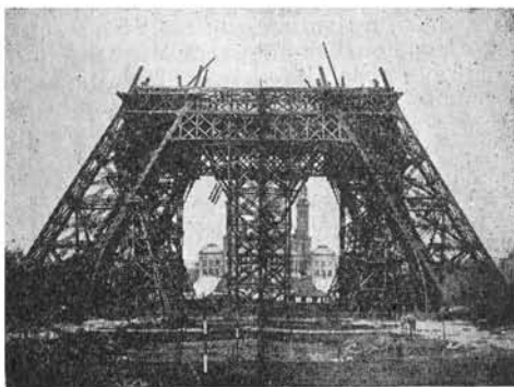
La tour Eiffel en cours de construction (1888)
