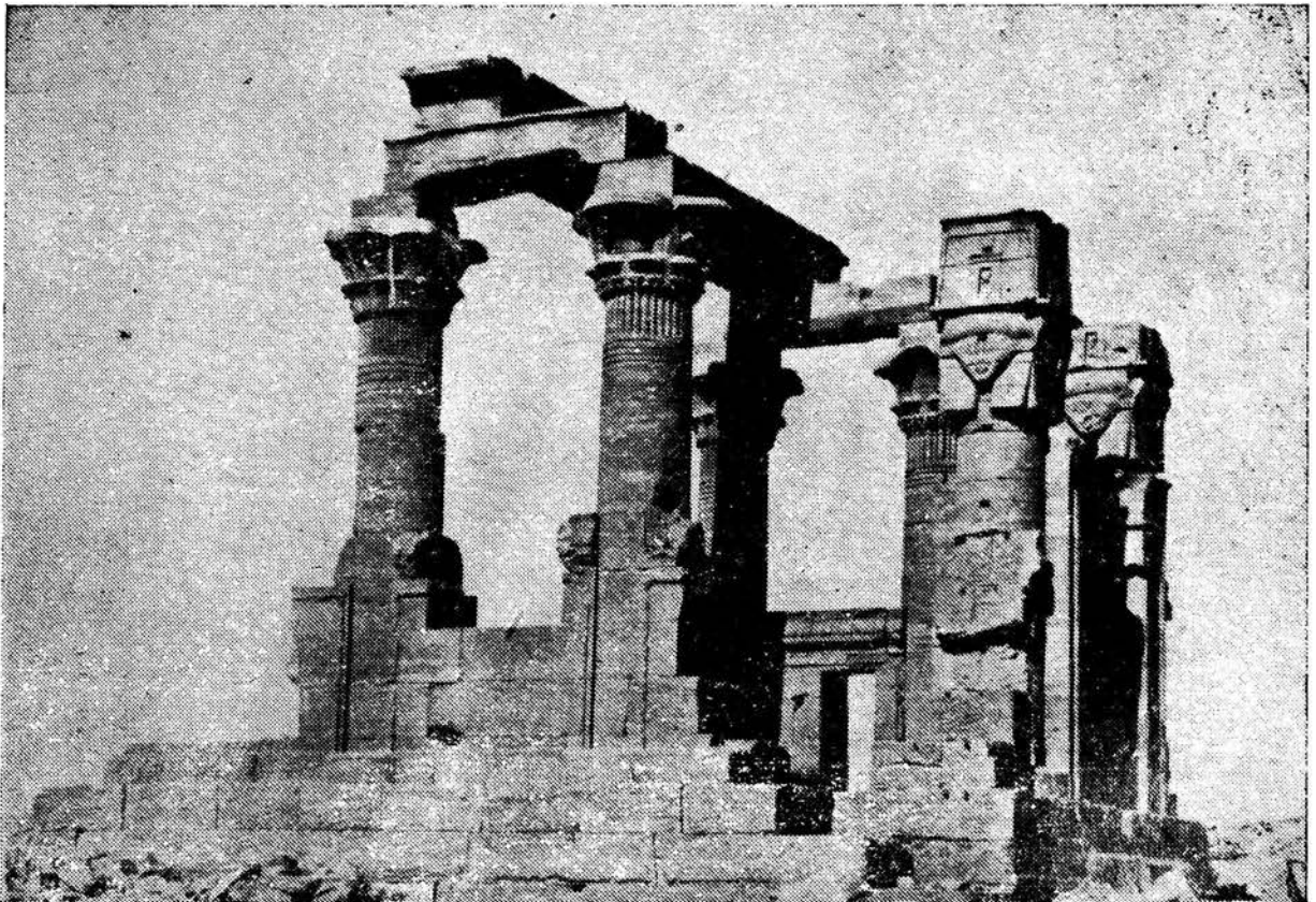
Le kiosque de Kirtassi après les travaux de Barsanti en 1908.
