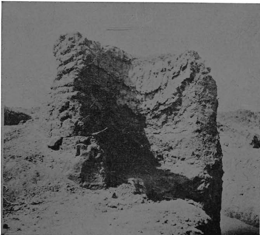
Fig. 8. — Le four pour la fabrication de la chaux.
