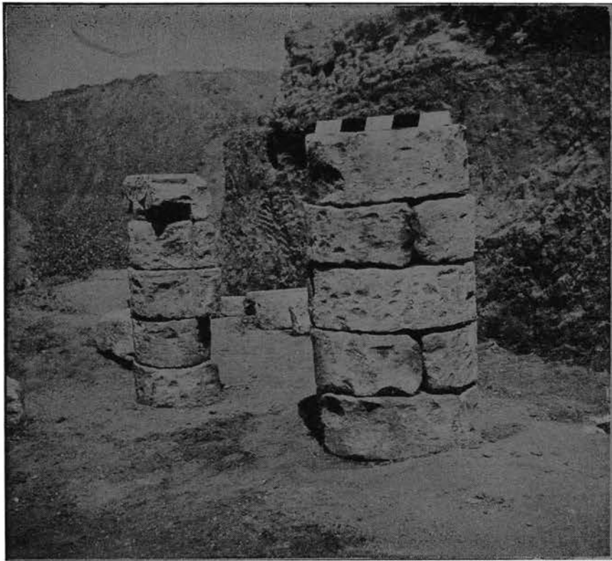
Fig. 7. — Essai de restauration des colonnes.
