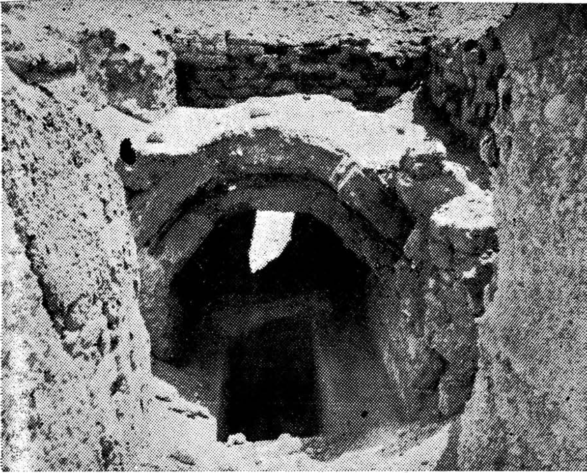
FIG. No. 1. — Fouilles de Héliouan. Voûte par tranches inclinées en briques crues. 1ère dynastie.
