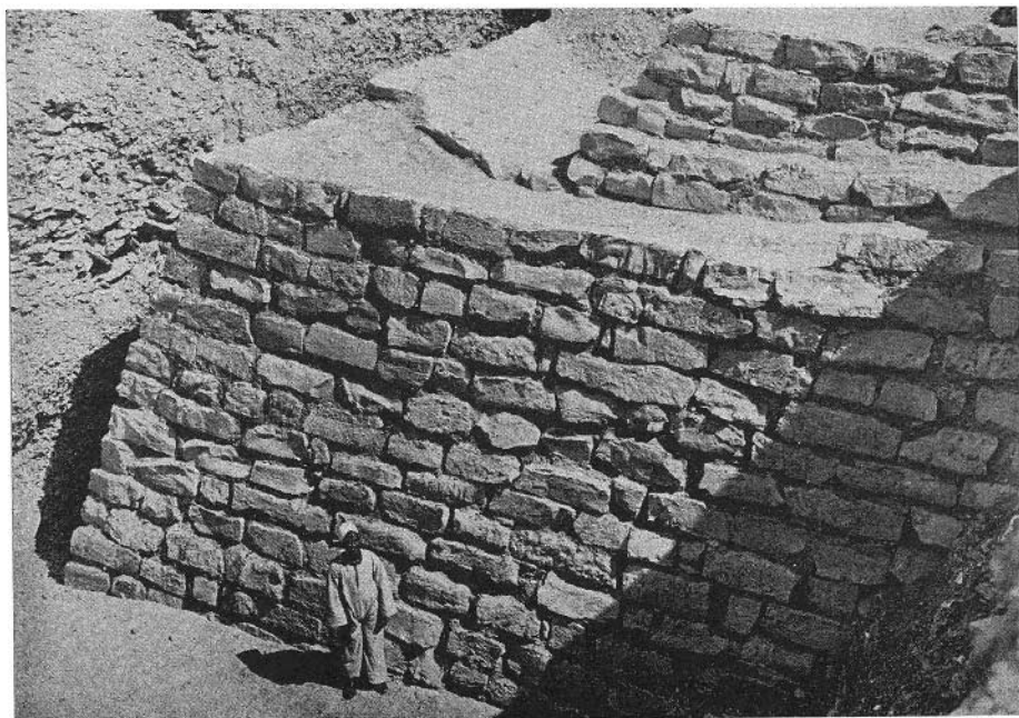
21. Angle nord-ouest de la nouvelle pyramide à degrés.
